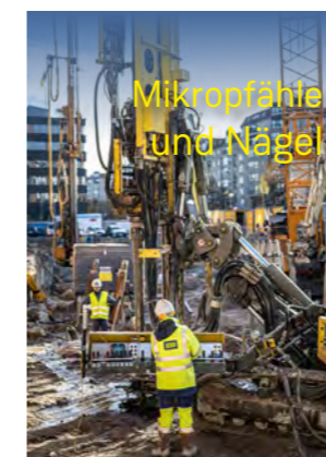
Verdrängungs- bohrpfähle
