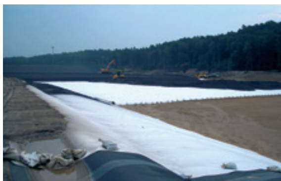
Herstellung der Basisabdichtung „Grube Präsident“
