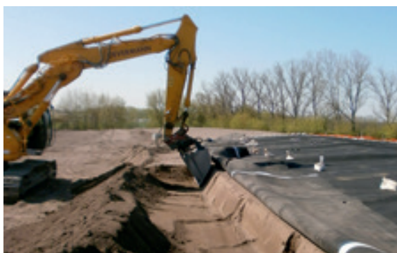
Herstellung des Einbindegrabens in Beeskow
