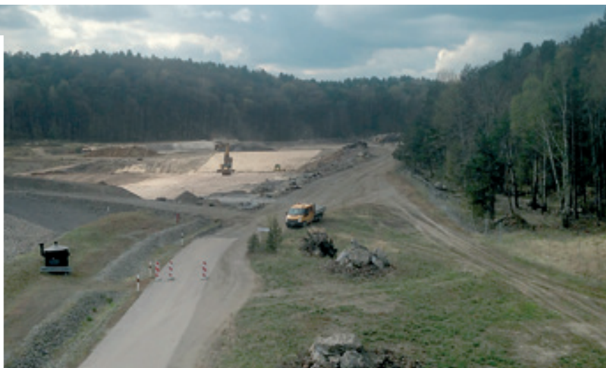
Profilierung der Deponiebasis in Eisenhüttenstadt
