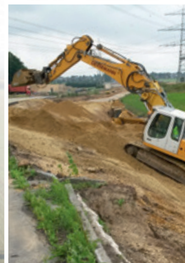
Herstellung einer provisorischen Zufahrt zum Anfüllen eines Damms
