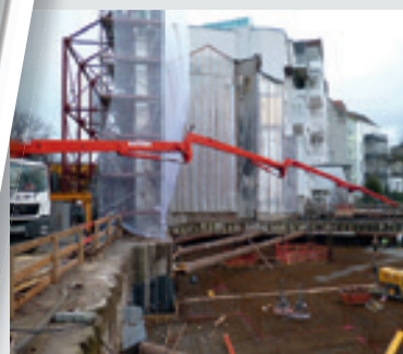
Betonage auf engstem Raum
