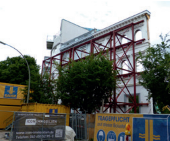
Historische Fassade - bauzeitlich gesichert
