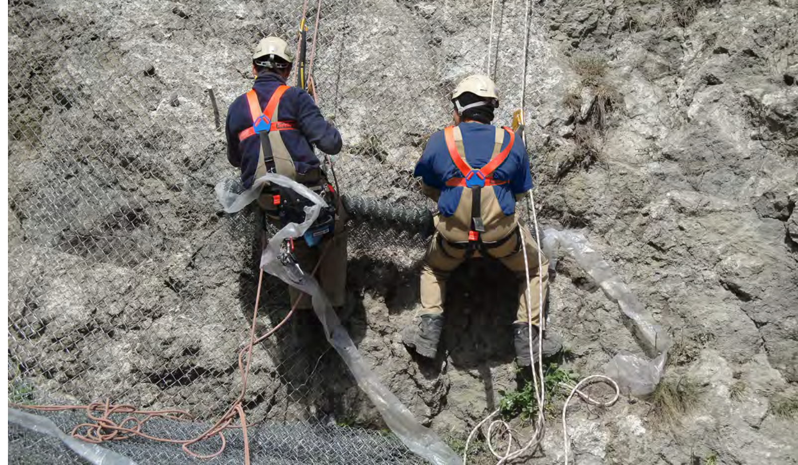
Sicherung einer Felsböschung mit Felsnägeln und Schutznetz
