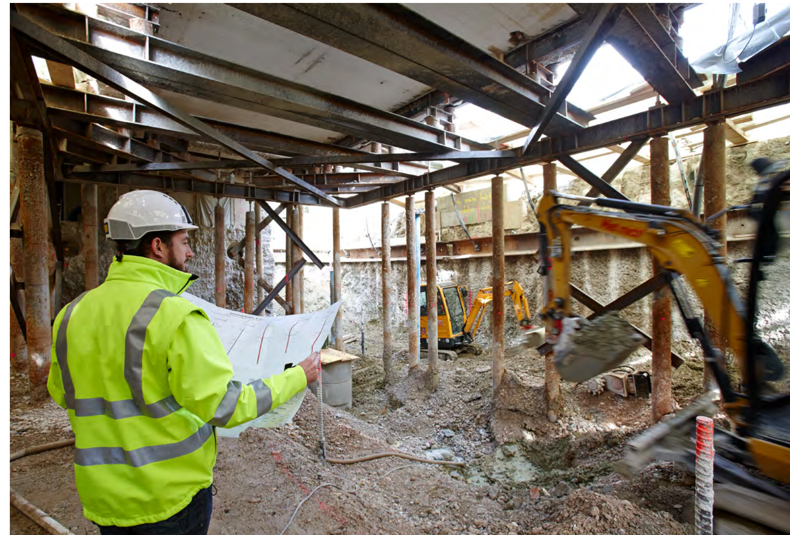
Temporäre Abfangung mit Mikropfählen
