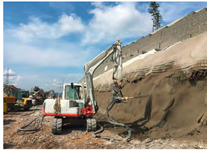
A46, Bestwig, Aufbringen des Spritzbetons
