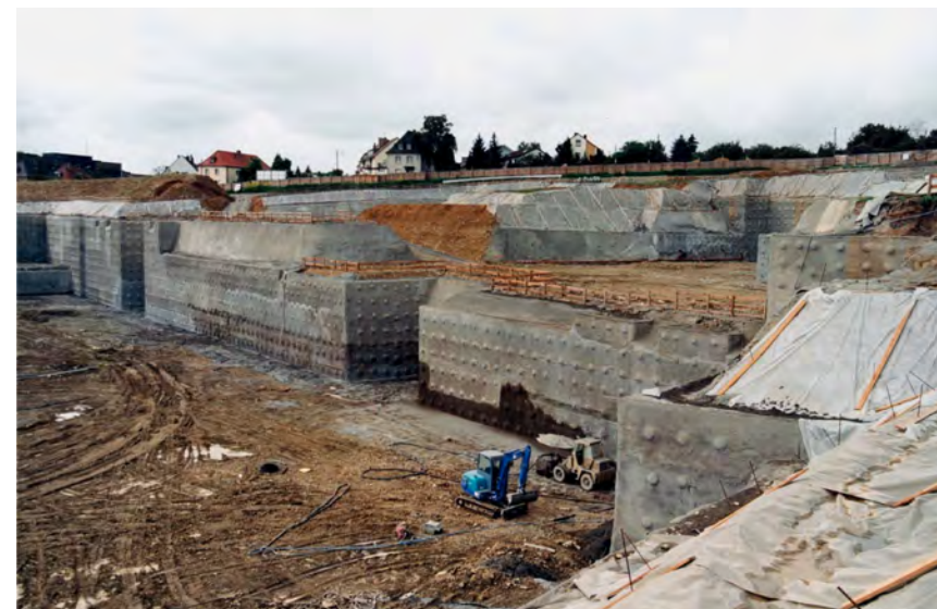
Universitätsklinik, Würzburg, Bodenvernagelung System Stump
