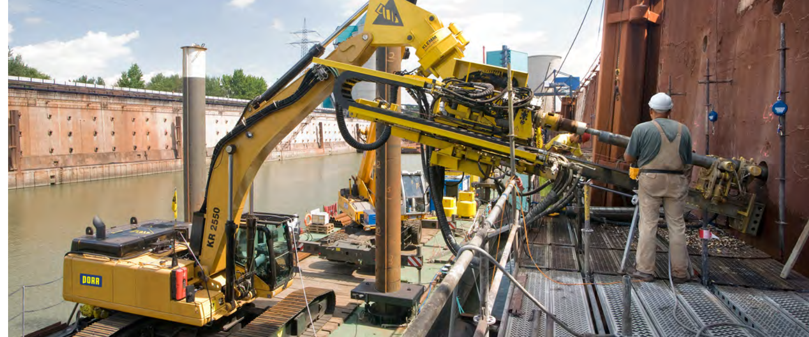
Rückverankerung mit Bohrverpresspfählen, Duisburg Werkschafen HKM
