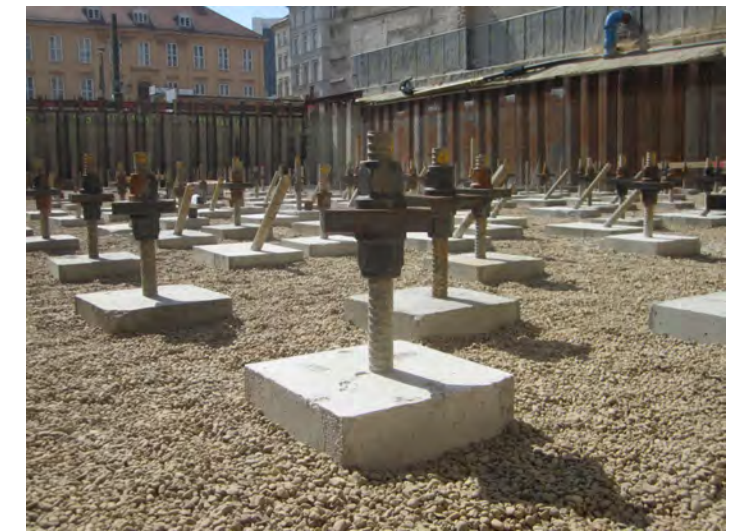
Pfahlköpfe mit Verankerungsplatten
