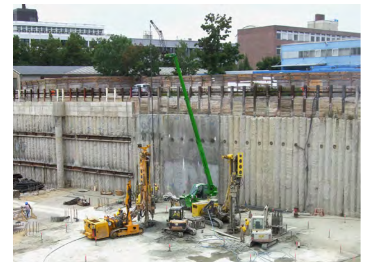
ADAC, München, Verbundpfahl System Stump
