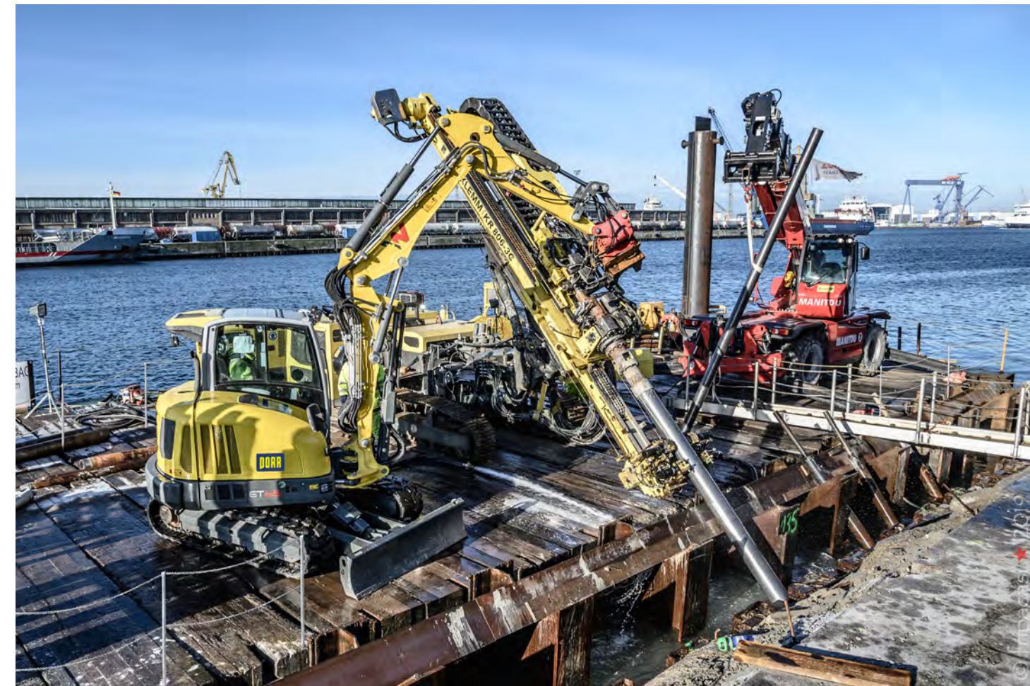
Überseehafen Rostock: Kaimauersicherung mit Verbundpfählen, System Stump
