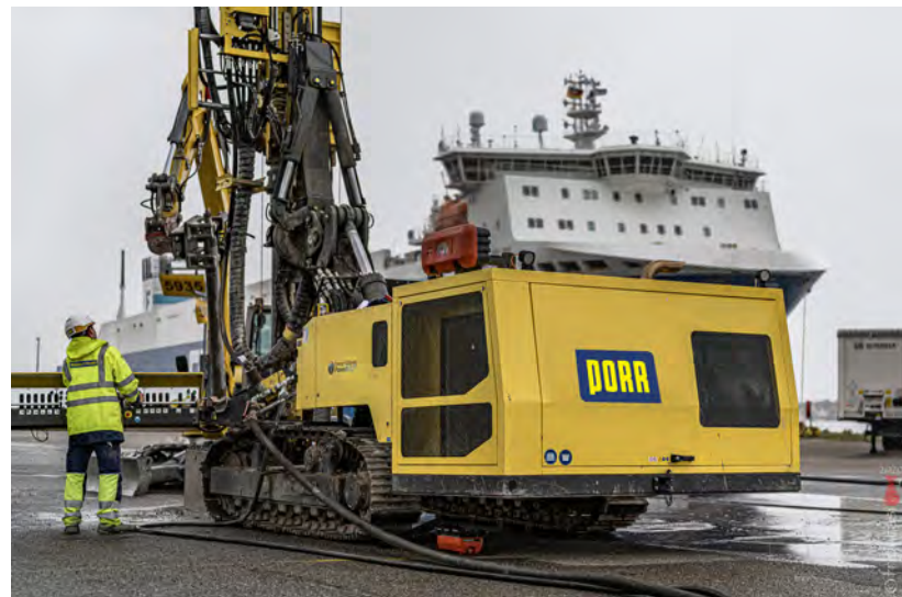
Travemünde, Skandinavienkai, Verbundpfähle
