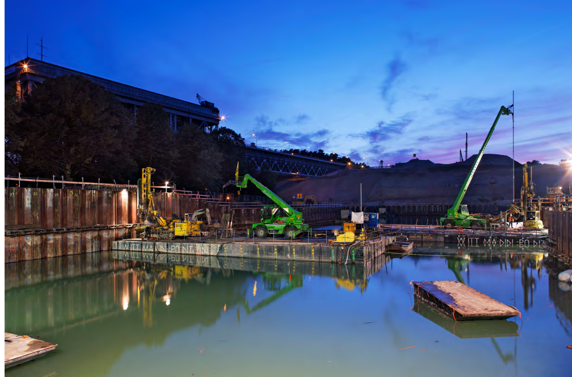
Schiffshebewerk, Niederfinow, Verbundpfahl System Stump
