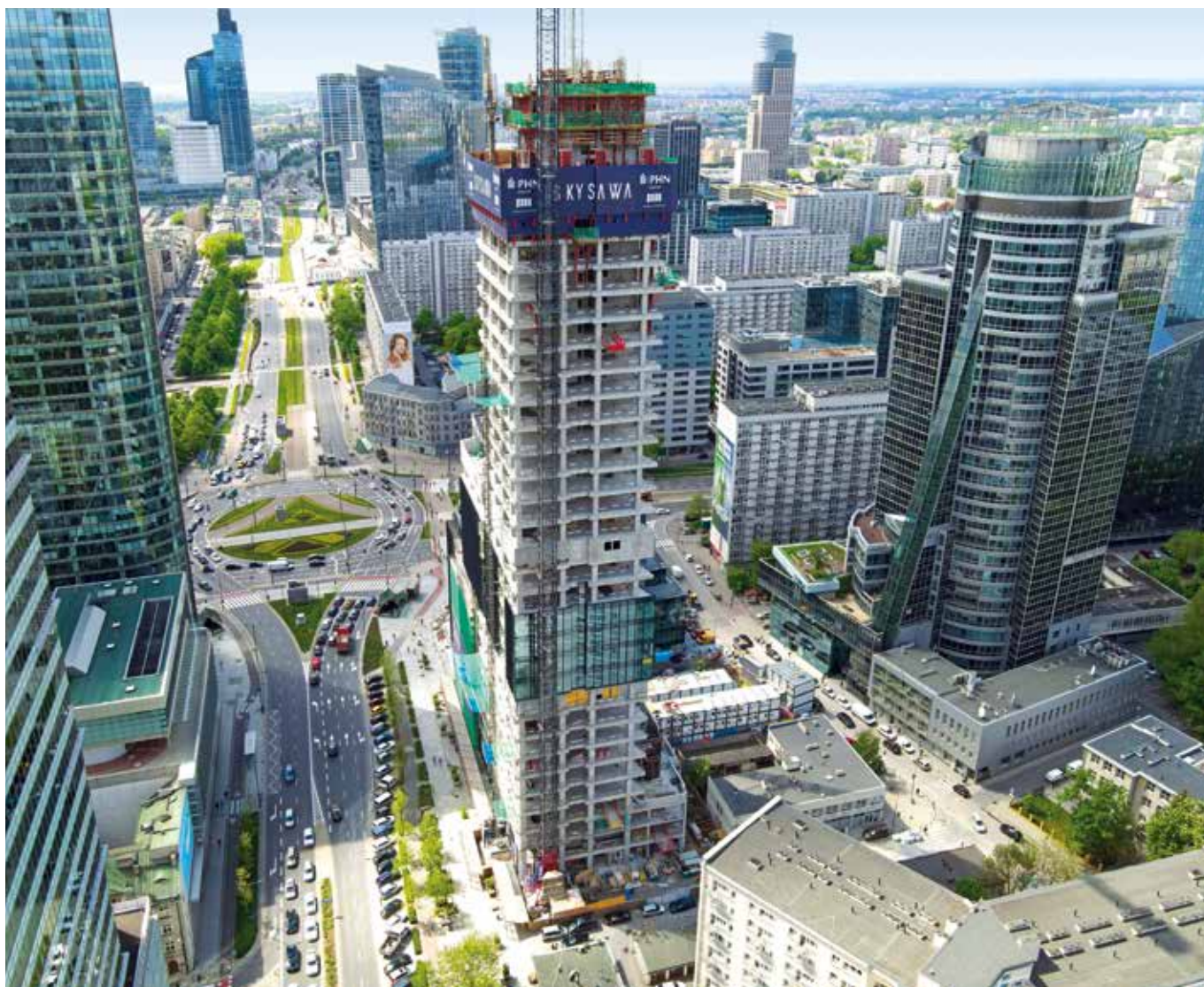
Ein Turm der Rekorde: Der 155 Meter hohe Bleistift-Wolkenkratzer SKYSAWA prägt mit 40 Geschossen und einer Gesamtfläche von 40.000 Quadratmeter die Skyline von Warschau. Gebaut von der PORR, die mit zukunftsweisenden Technologien und Pioniergeist einmal mehr Rekorde aufstellt.
