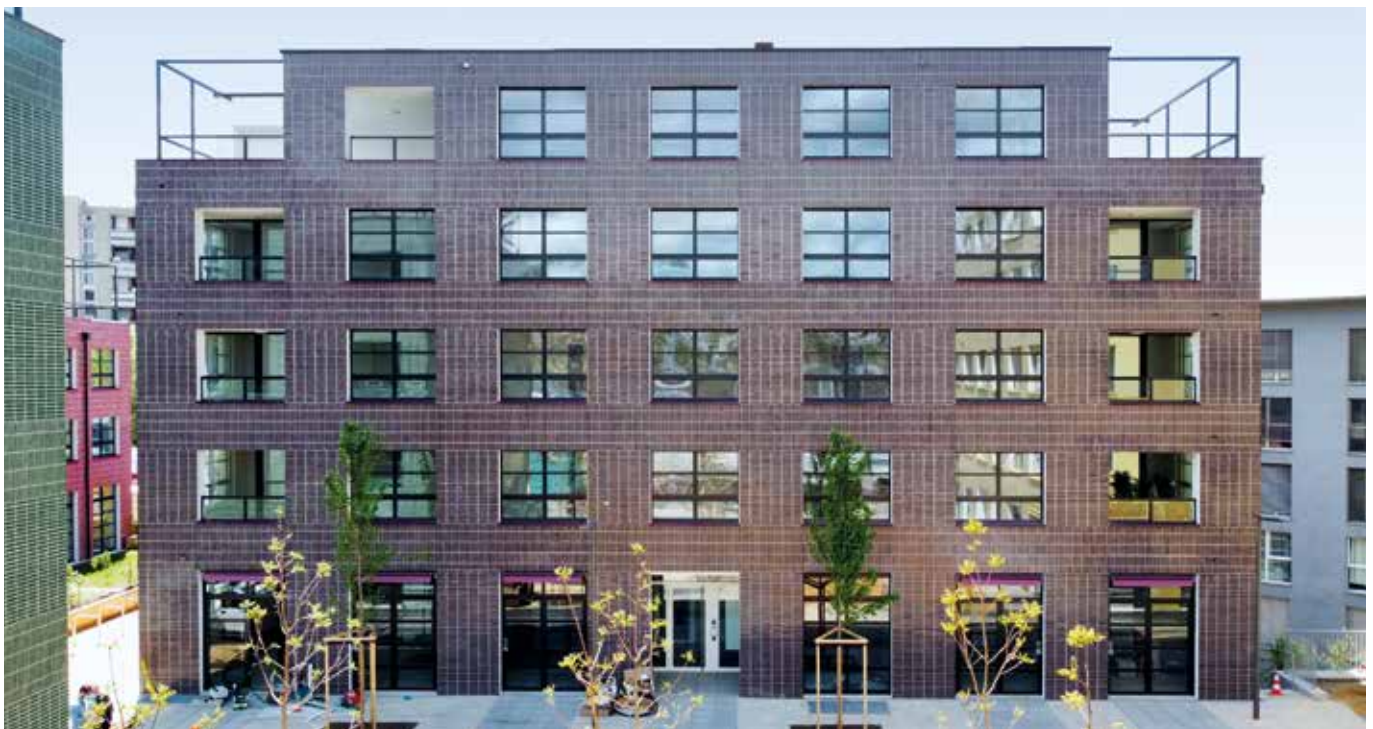
Beim Wohnprojekt Parc du Simplon in Renens in der Westschweiz setzte die PORR auf Kreislaufwirtschaft. Einen hohen Anteil an den Baustoffen machten Recyclingmaterialien aus. Boden und Aushub wurden vor Ort wiederverwendet.
